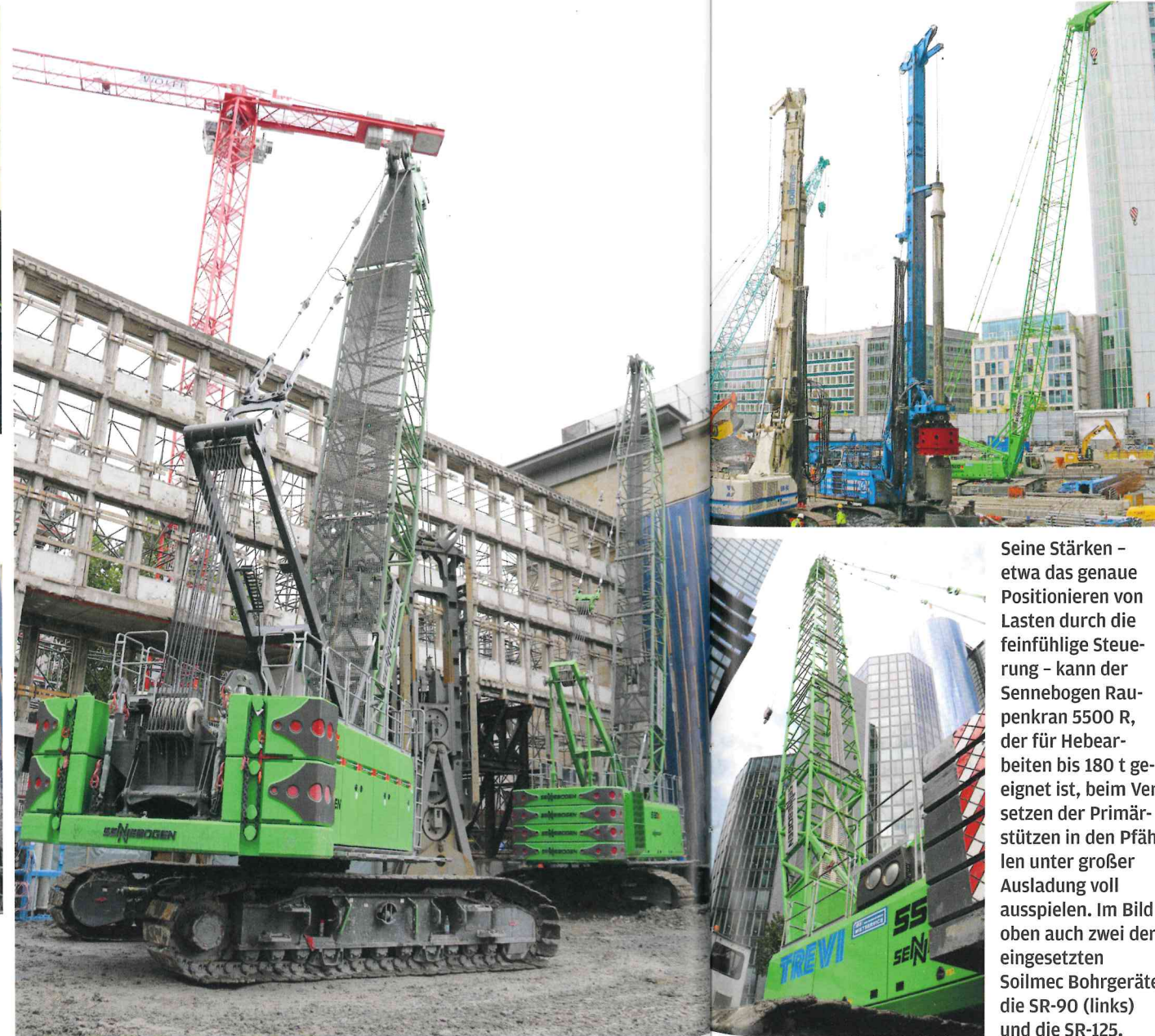
Sennebogen Seilbagger im Schlitzwandeinsatz: rechts der 6140 E, der sich hervorragend für den Spezialtiefbau eignet, rechts im Hintergrund einer der beiden 6130 E. Für die Errichtung der Schlitzwände kommt auch einer der größten Greifer der Firma Stein HT zum Einsatz, montiert am Sennebogen 6140 E.
