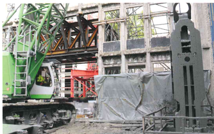
Sennebogen Seilbagger im Schlitzwandeinsatz: rechts der 6140 E, der sich hervorragend für den Spezialtiefbau eignet, rechts im Hintergrund einer der beiden 6130 E. Für die Errichtung der Schlitzwände kommt auch einer der größten Greifer der Firma Stein HT zum Einsatz, montiert am Sennebogen 6140 E.
